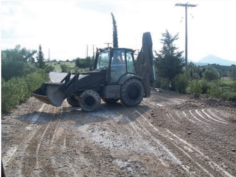
Εικόνα 22: Διάνοιξη δρόμου (ΣΞ)
