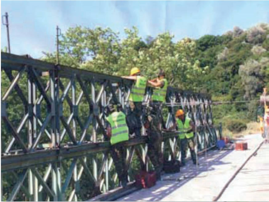
Εικόνα 20: Επισκευή γέφυρας τύπου «Bailey» στη Μπολιάνα Θεσπρωτίας (ΣΞ)
